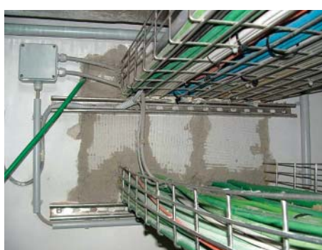
Проходки из огнестойких плит
